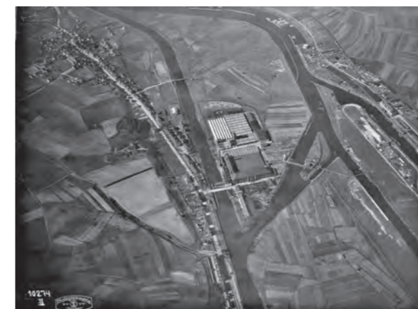
Gaustadt und die Erba-Insel 1930. Der Werkskanal und die Regnitz schließen die große Erba-Insel ein. Durch den Bau der Schleuse ist südöstlich davon eine weitere kleine Insel entstanden. Deutlich sichtbar, die Straße, die von der Erba mit Brücken über den linken Regnitzarm, den Schleusenkanal und den rechten Regnitzarm zum Hafen führt.
